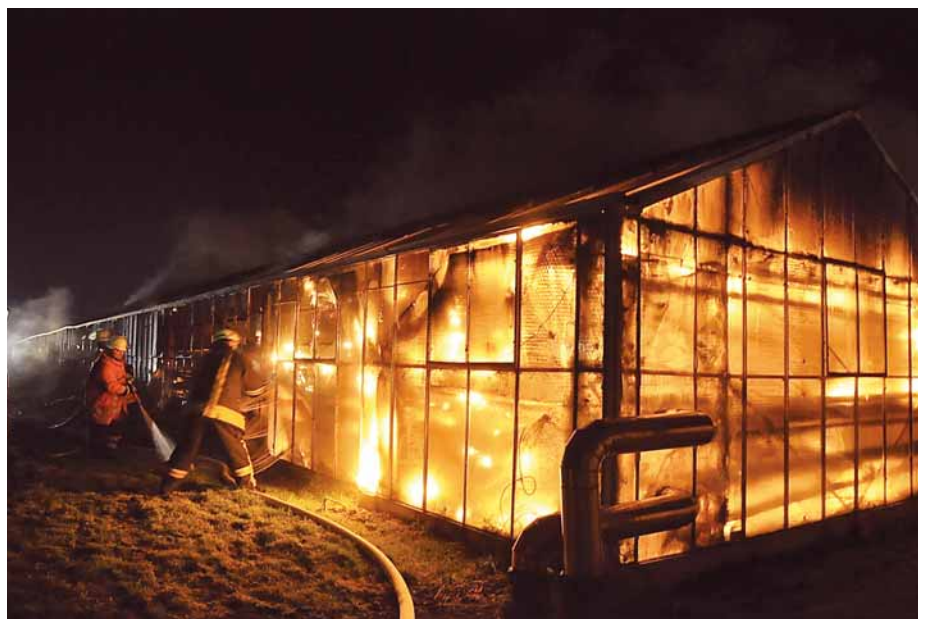
Großbrand auch in einem Betrieb in Norddeutschland: Das Ausmaß des Schadens ging vor allem auf leicht entflammbare (B3-) Schirmtücher und die darunter befindlichen Kunststoff-Tischauflagen zurück.
